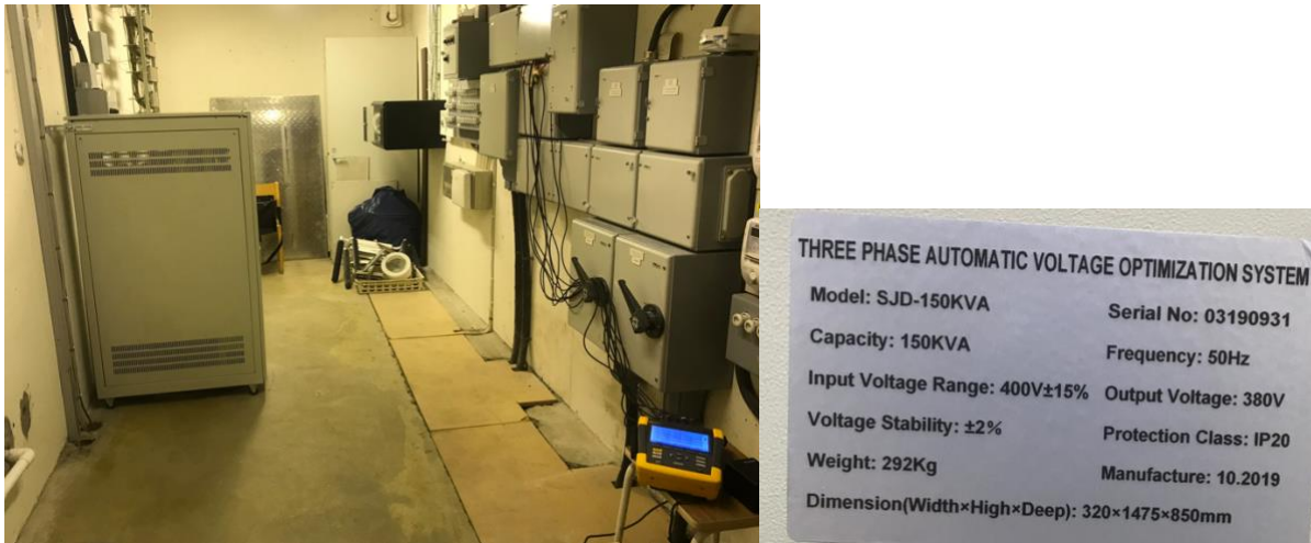
Bild 1 Fluke 438-II inkopplad i el servisen Kryddgården
